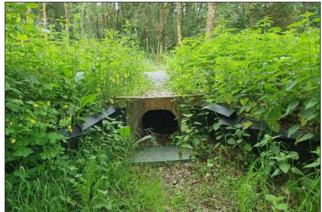
Figure 19. Passage à petite faune reliant le coteau boisé et le marais © Gabrielle Huart
