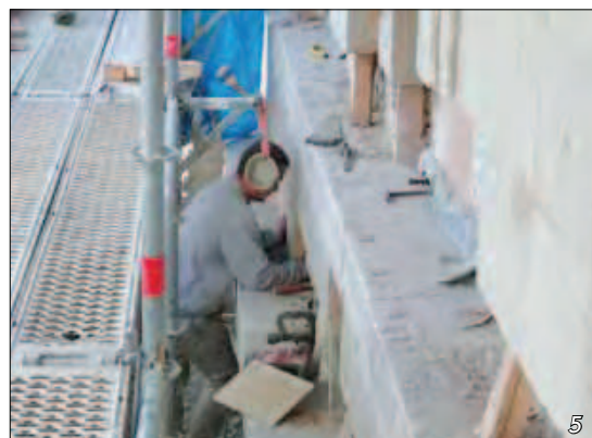
Remplacement, sur les façades du théâtre de la Halle-au-Blé, des pierres de tuffeau endommagées (photos 4 et 5).
