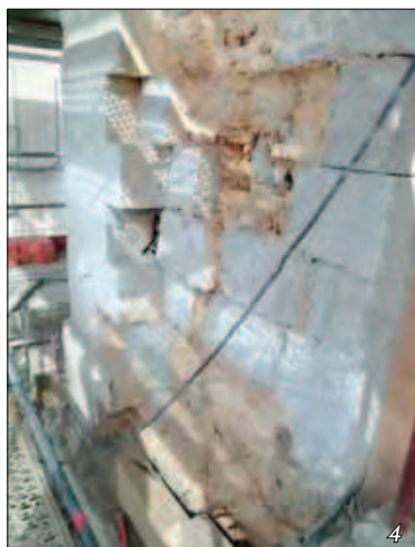
Remplacement, sur les façades du théâtre de la Halle-au-Blé, des pierres de tuffeau endommagées (photos 4 et 5).
