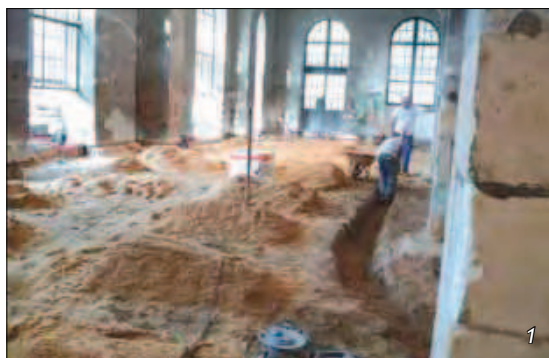
Travaux de terrassement dans les halles pour la pose des caissons qui serviront au système de traitement de l'air. L'architecture particulière des lieux a nécessité une installation en sous-sol sur les deux travées (photos 1, 2, 3).
